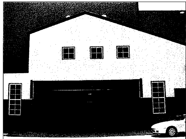
Loading Bay (Berkeley, CA)
