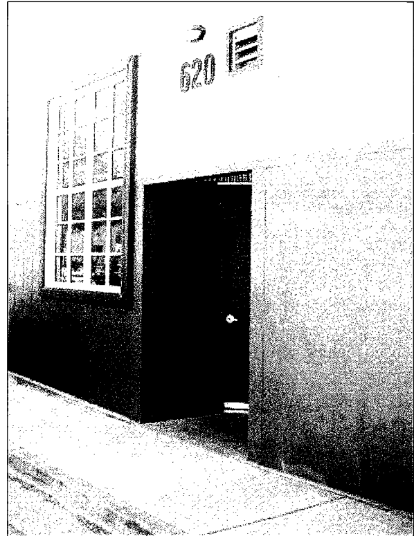
Appropriate recessed man door entry (Berkeley, CA)
